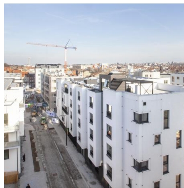
Chantier en cours, 2018
