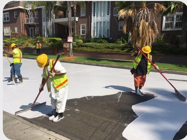
Application d'une peinture réfléchissante à Los Angeles – Source : RIBA Journal
