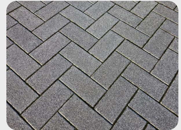
Pavés perméables en béton – Source : Bruxelles Environnement, © Mabel Amber
