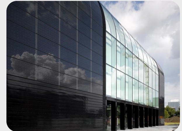
Parement en PV au BEL - Source : Bruxelles Environnement
